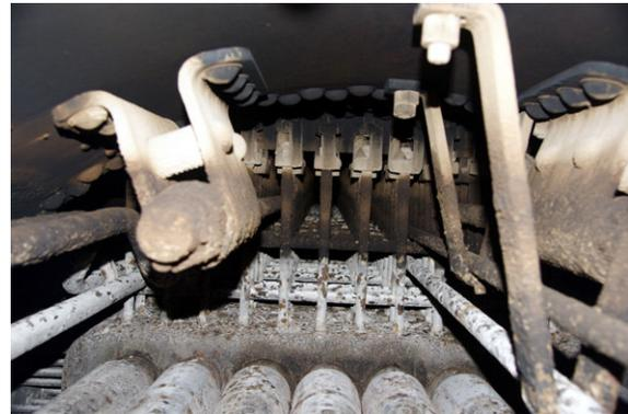
En fonctionnement cette zone est noyée. Des tirants sont disposés pour maintenir en position les parois de la chaudière face aux 17 barres de pression exercés sur la paroi
