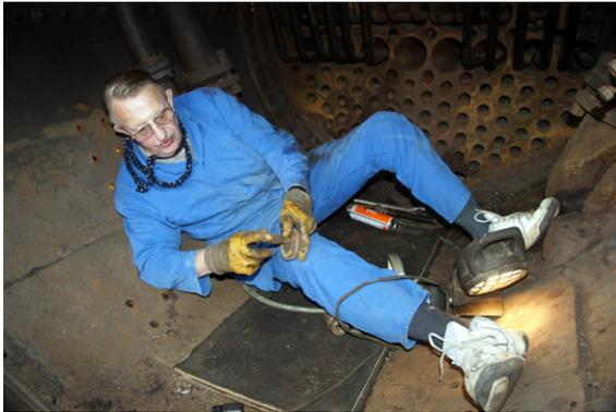
De nombreux bouchons métalliques sont déposés et soigneusement étiquetés puis entreposés
