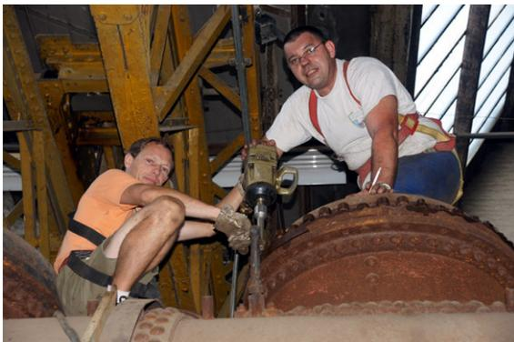
La dépose des 44 écrous de fixation du dôme situé au dessus de la chaudière aura pris 3 samedis après midi
