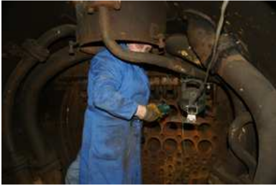
Les tubes déposés, Bernard entame le ramonage des tubes principaux et le nettoyage de la boîte à fumée.
