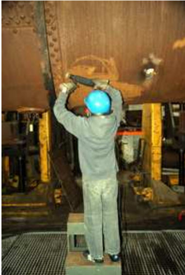
Le nettoyage du corps de la chaudière représente un très gros travail. Ici Alexandre s'attelle à la tâche.
