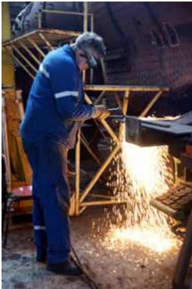
Pour l'épreuve de la chaudière il va être nécessaire de boucher l'ensemble des orifices de cette dernière. Des bouchons dans de l'acier de 10 vont devoir être fabriqués. Paul entame ici le découpage d'une de ces pièces au chalumeau.
