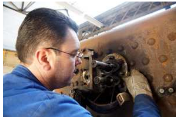
Dernière pièce à déposer de la chaudière : le support de commande des régulateurs BP et HP. La dépose de cette pièce nécessitera 9 mois d'effort !
