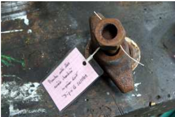
Ici un bouchon auto-clave fraîchement déposé, repéré et étiqueté. Il va être nettoyé et son joint à base d'amiante remplacé.
