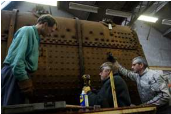
Dépose des supports de crinoline sur le corps de la chaudière par Xavier, Paul et Pierre.
