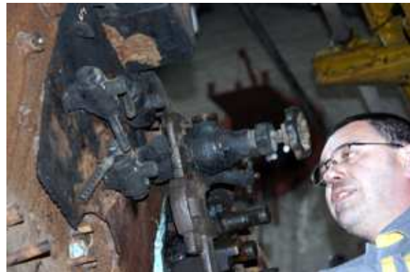
Ici Jean Pierre démonte une vanne.
