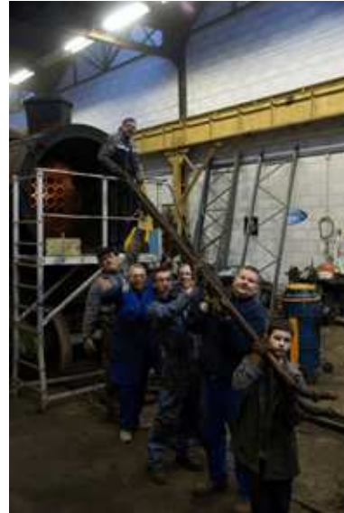
En novembre 2009, le 32 ème et dernier tube de surchauffe est déposé.
