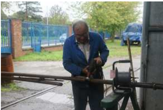
Au second semestre 2010 le début du nettoyage des tubes de sur-chauffe commence.
