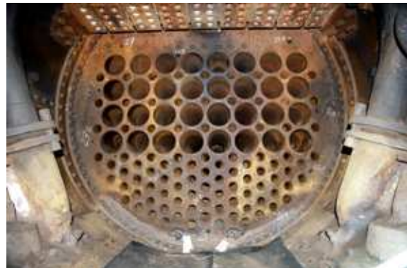
Intérieur de la boîte à fumée nettoyée.
